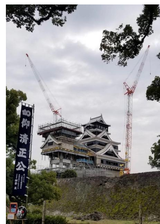
復興工事中の熊本城
